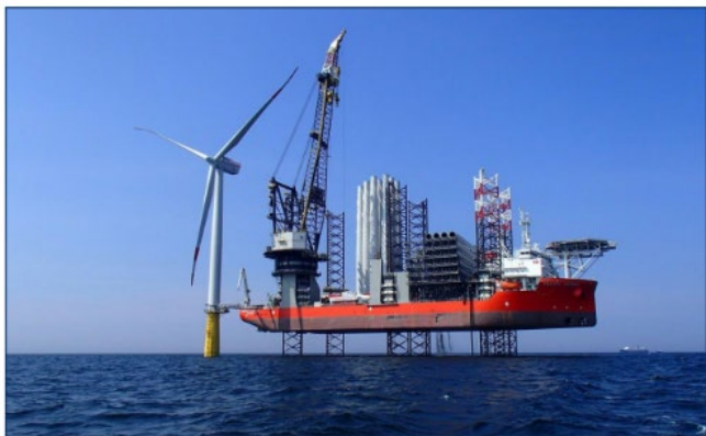
installation av havsbaserad vindkraftverk
