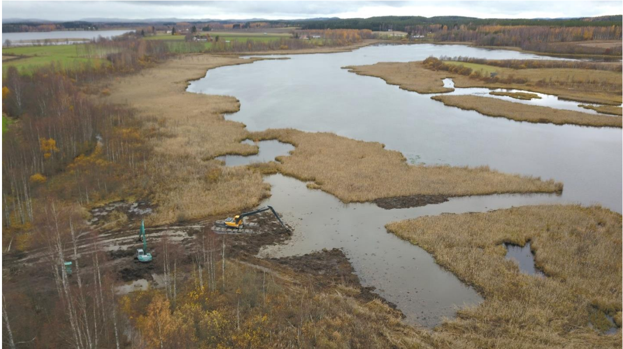
Kaivutöitä Keskimmäisellä pitkäpuomisella telaponttoonikaivinkoneella lokakuussa 2018.
