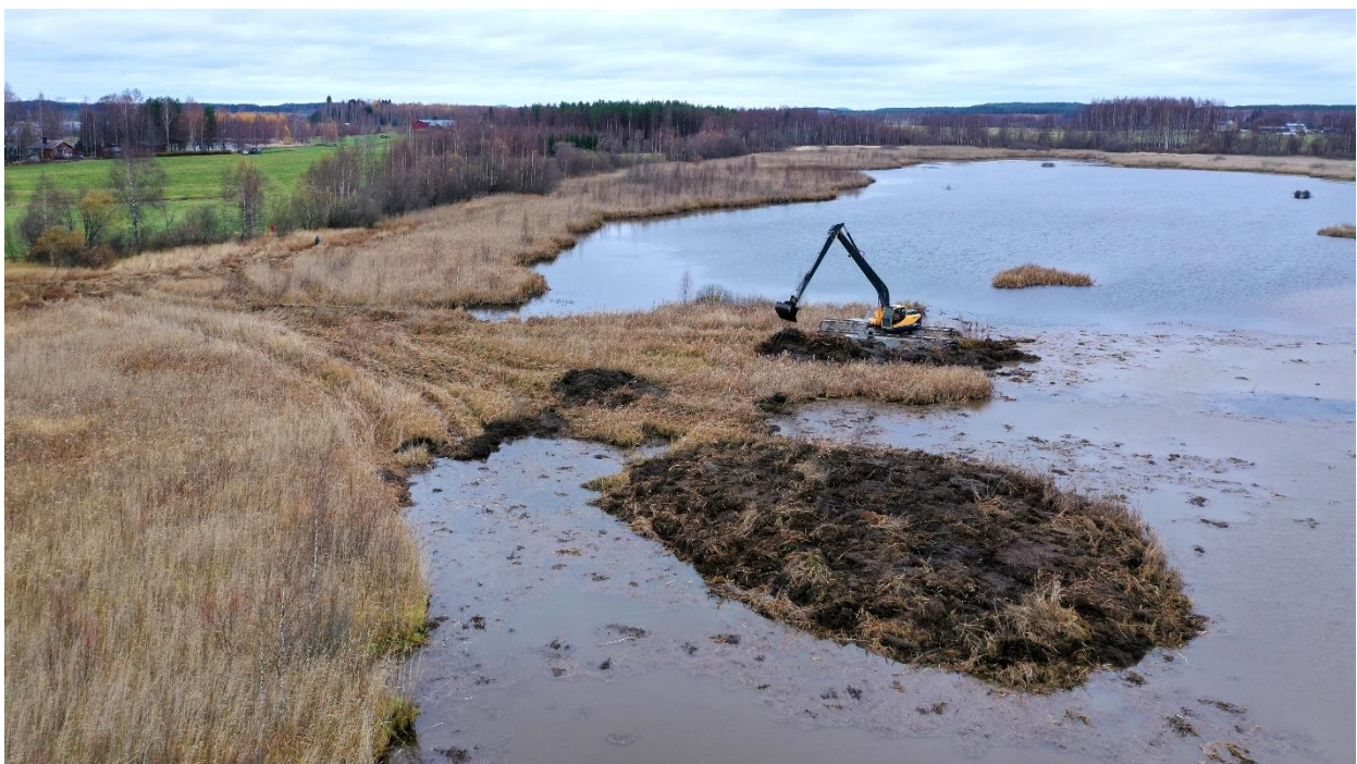
Likolammen kaivutöiden alku lokakuussa 2021.
