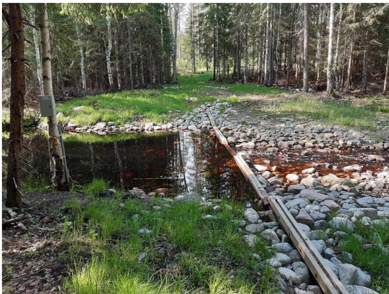
Kuolemaisien pohjapato runsas vuosi rakentamisen jälkeen.
