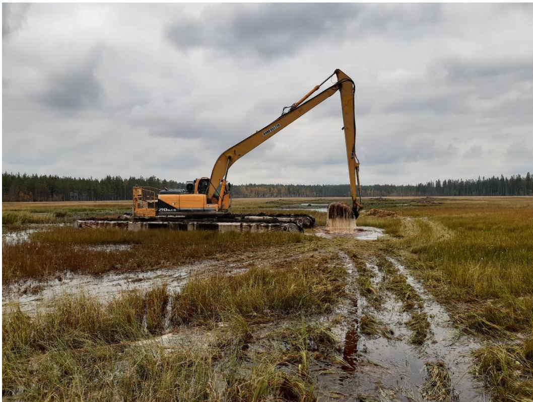
Valkeisenjärveä ruopattiin kelluvalla kaivinkoneella.
