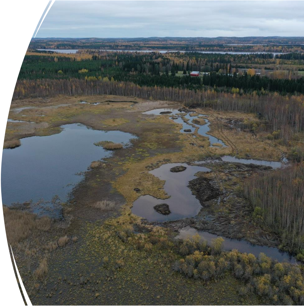
Keskisenlammen etelärannan ruoppaustyöt käynnissä.
