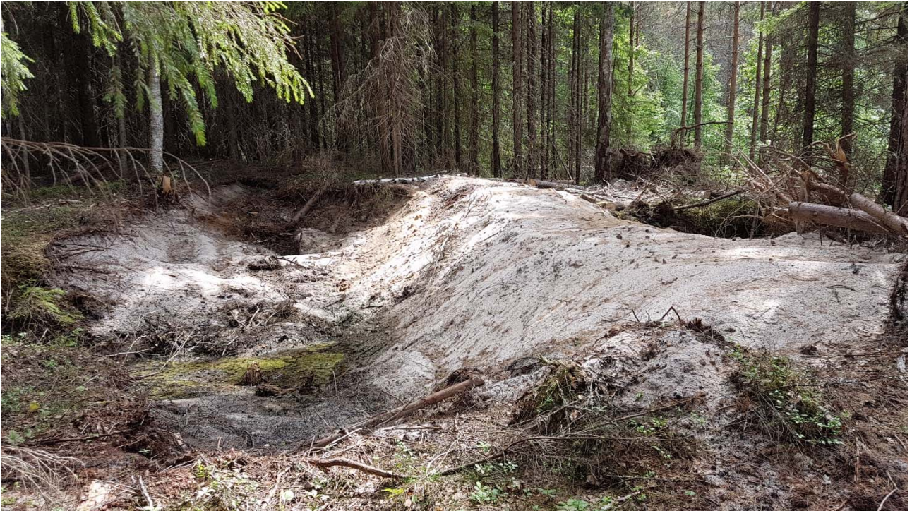
Kuva 7. Lauhanvuorella on tukittu kivennäismaille ja korpiin kaivettuja ojia tekemällä reippaan kokoisia patoja.
