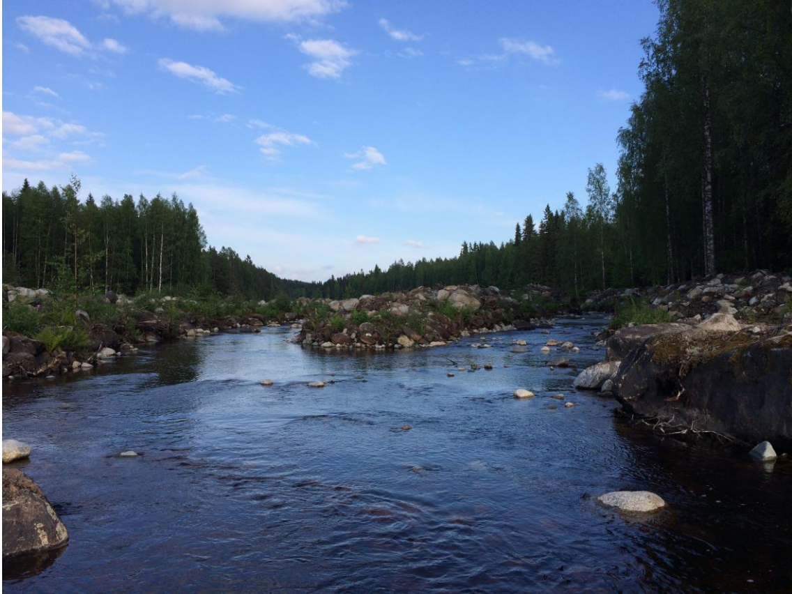
Kuva 4. Kuusamonkosken uudet kunnostetut uomat alavirrasta katsottuna. Sammalkiviä siirrettiin kuvassa oikealla näkyvään uomaan.
