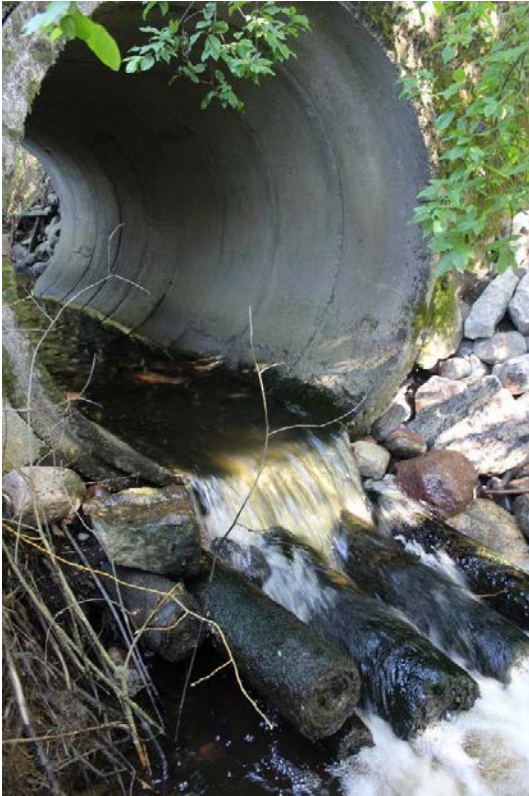
Kuva 6. Kuva Juottimenojan tierummusta ennen kunnostuksia. Kuva 7. Juottimenojan tierumpu kunnostusten jälkeen. Tierummun alapuolelle rakennettiin noin 70 metrin pituinen koski.
