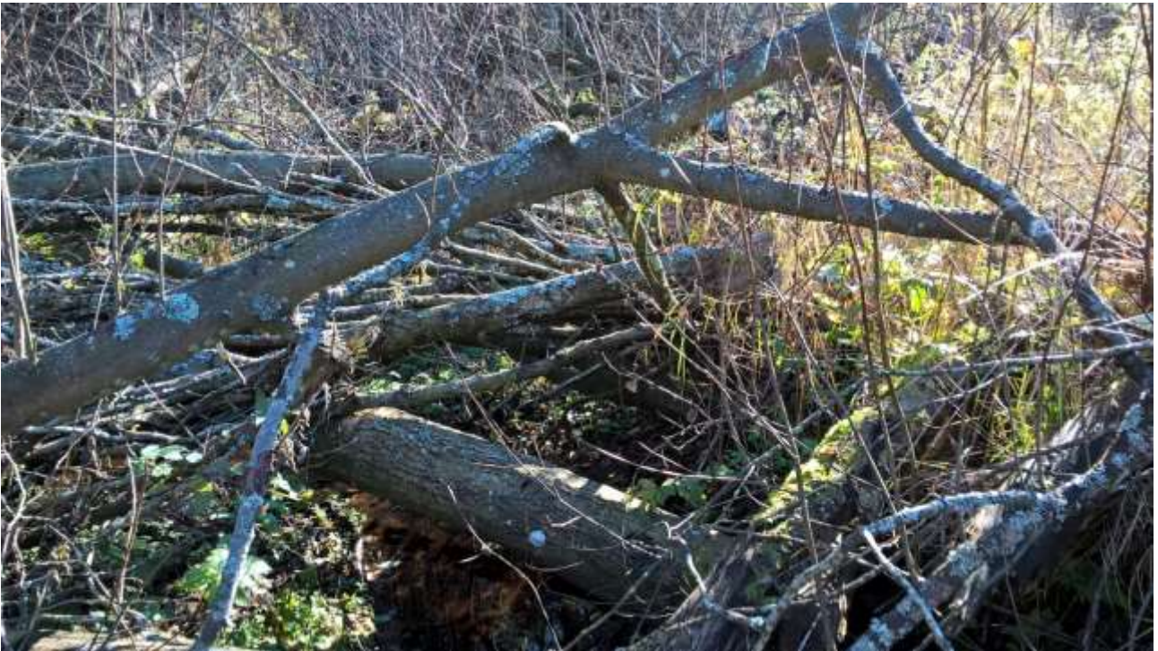
Kuva 16. Umpeenkasvanutta sivu-uomaa keskiosalla, jonka uudelleen vesittämistä voidaan myöhemmin jatkoselvittää.
