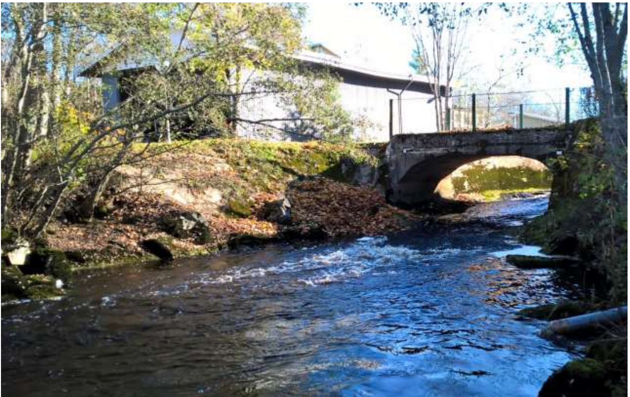
Kuva 8: Villamon patoalueen silta sekä taustalla betonikanavan alaosa. Sillan alapuolelle rakennetaan uomaan kolme pohjapatoa. Sekä betonikanavan alueelle että varsinaiseen jokiuomaan tehdään vesisammallistutuksia.
