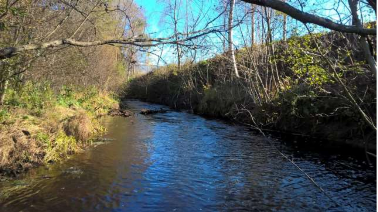
Kuva 17. Keskiosan kunnostuksessa uomaan lisätään kiviryhmiä ja kutusoraikkoja sekä suisteita. Etelärannan varjostusta pyritään lisäämään.
