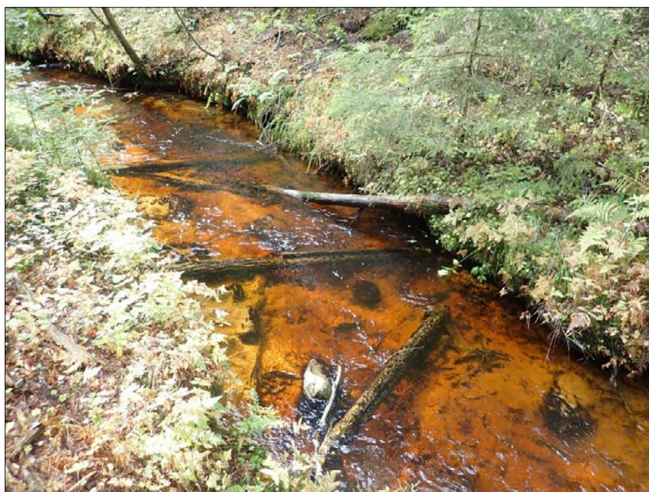
Kuva 13. Puusuisteita ja kiviä Myllyojassa. Puusuisteilla on saatu uoman pohjaan haluttuja muutoksia ja vaihtelevuutta.
