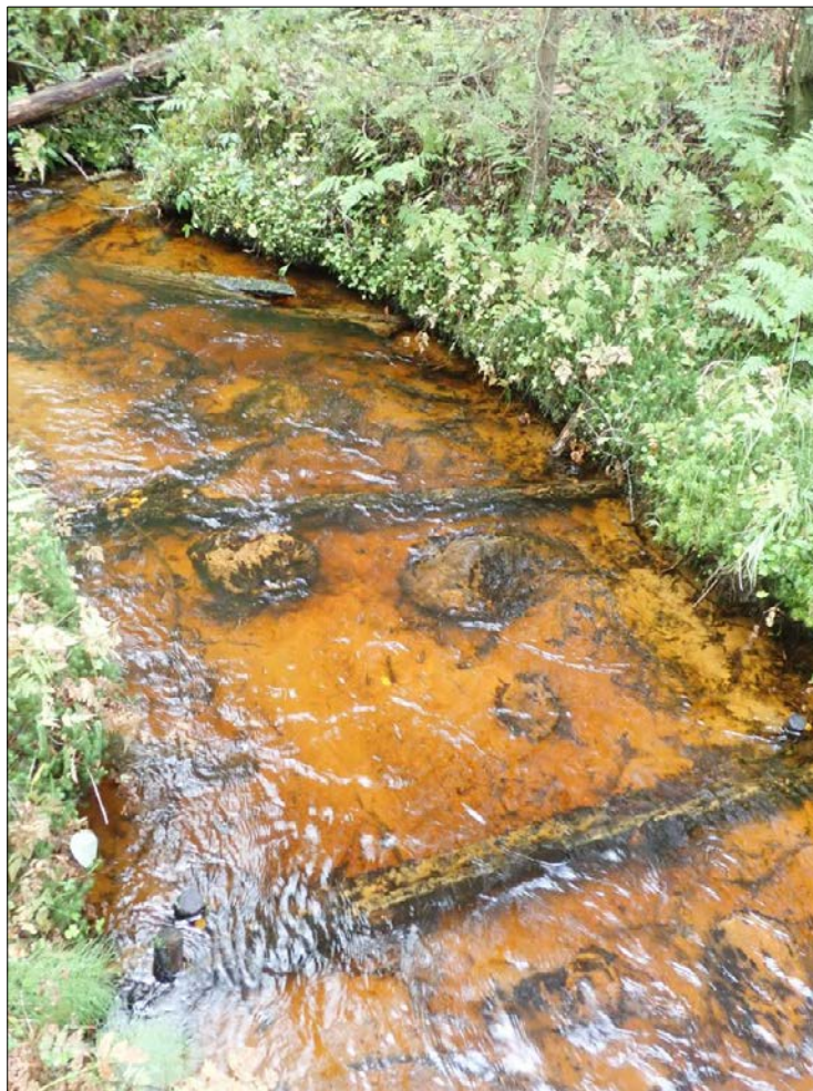
Kuva 12. Kunnostettua Lohiluoman tyyppistä hiekkamaan lähdevetistä puroa Karviajoen vesistöalueella (Myllyoja). Uomaan lisätty puuta ja kiviä.
