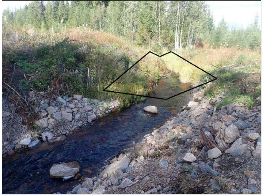
Kuva 11. Suunnittelualueen alaosalla, sähkölinjalla on uoman reunat kivetty metsätien remontin yhteydessä. Kiveyksen yläpuolelle avoimelle alueelle olisi suositeltavaa laskeutusallas kiintoaineen kulun hidastamiseksi.
