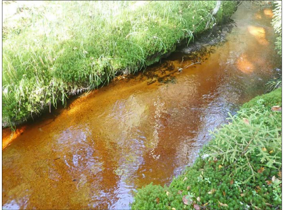
Kuva 7. Lohiluoma on aikanaan kaivettu syvemmäksi, mutta juoksettuva hiekka on mataloittanut sitä kauttaaltaan.
