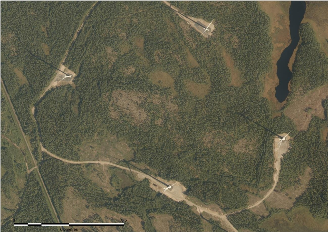
Kuva 5-1. Ilmakuva rakennetusta tuulivoimapuistosta.
