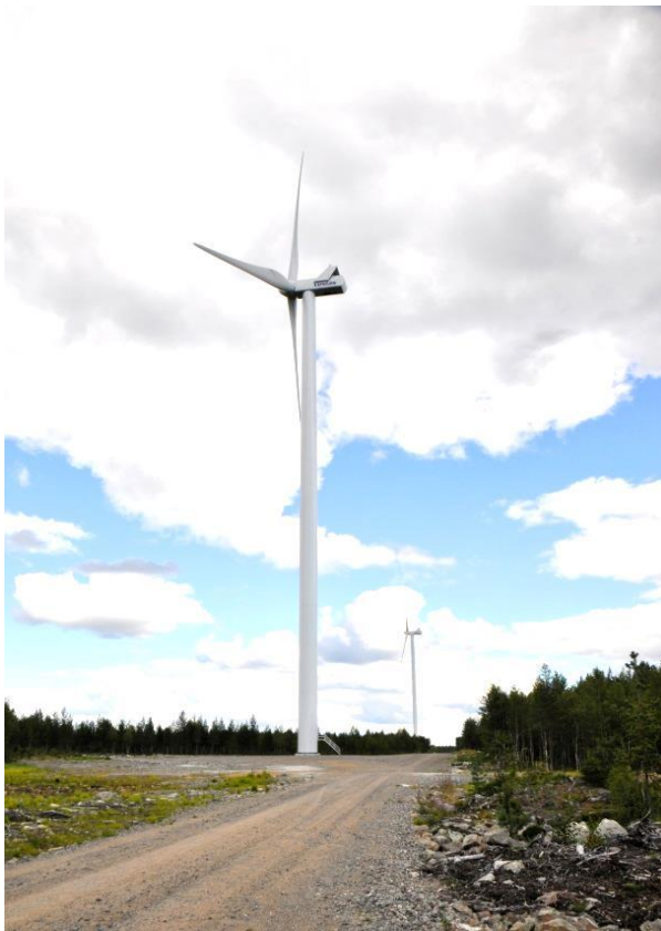
Kuvapari 5-2. Vasemmalla on esimerkki teräslieriötornista ja oikealla hybriditornista (Kuvat: Leila Väyrynen ja Ville Suorsa, FCG).
