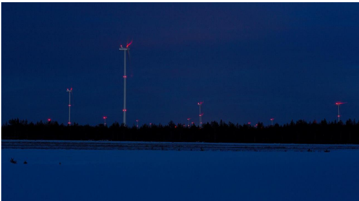
Kuva 5-5. Kiinteät punaiset lentoestevalot (Kuva: Ville Suorsa, FCG).
