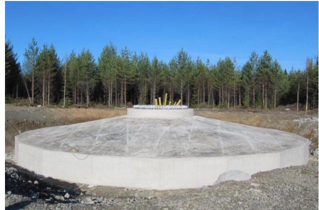
Kuvapari 5-12. Tuulivoimalan perustusten rakentamista (Kuvat: Leila Väyrynen/FCG).
