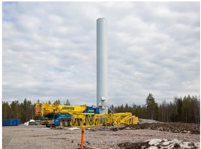
Kuvapari 5-13. Tuulivoimalan kokoamista (Kuvat: Ville Suorsa/FCG).
