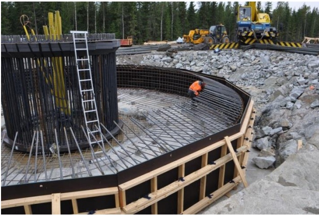
Kuvapari 5-12. Tuulivoimalan perustusten rakentamista (Kuvat: Leila Väyrynen/FCG).
