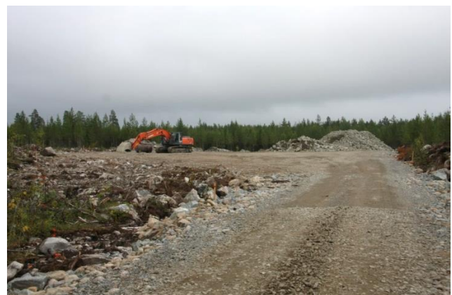
Kuvapari 5-10. Tuulivoimapuiston rakentaminen alkaa huoltoteiden ja pystytysalueiden rakentamisella (Kuvat: Ville Suorsa/FCG).
