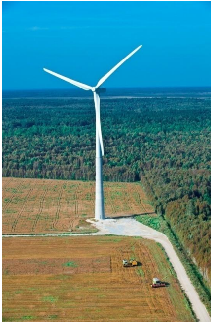
Kuva 3-7. Vasemmalla 3 MW:n tuulivoimalaitos, jonka tornin alaosa on betonia ja yläosa terästä, napakorkeus ja roottori ovat 100 m. (Kuva: WinWinD). Oikealla on periaatekuva tuulivoimalasta (Kuva: planete-energies.com).
