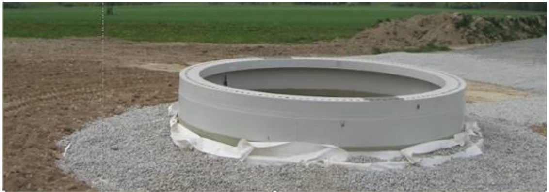
Kuva 3-10. Perustuksen rakentamisvaiheita. (Kuva: Ventureal).
