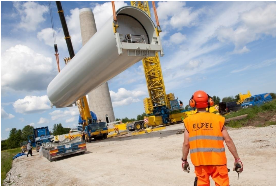
Kuva 3-14. Tornilohkon nostaminen (Kuva: Eltel Networks Oy).
