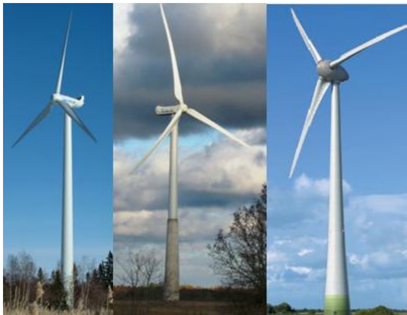
Kuva 3-8. Tuulivoimalan tornityyppejä, vasemmalla terästorni, keskellä betoni- ja terästornin yhdistelmä ja oikealla täysbetonitorni. (Kuvat: WinWinD ja Enercon).
