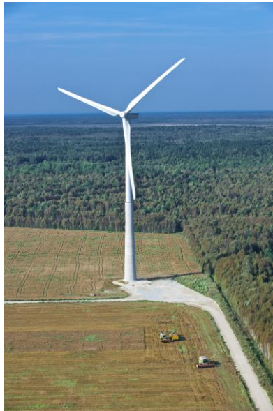
Kuva 4. Kuva 3 MW:n tuulivoimalasta, jonka tornin alaosa on betonia ja yläosa terästä sekä periaatekuva tuulivoimalasta (Lähteet: WinWind Oy, planete-energies.com)
