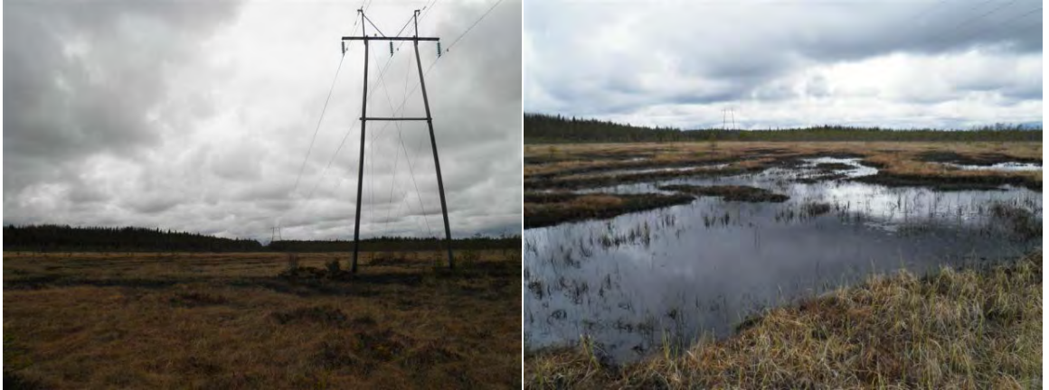
Kuva 24. Vasemmalla suon ylittävä nykyinen voimajohto, oikealla linjan alueen suorimpiä, joista havaittiin viitasammakon kutuääntelyä
