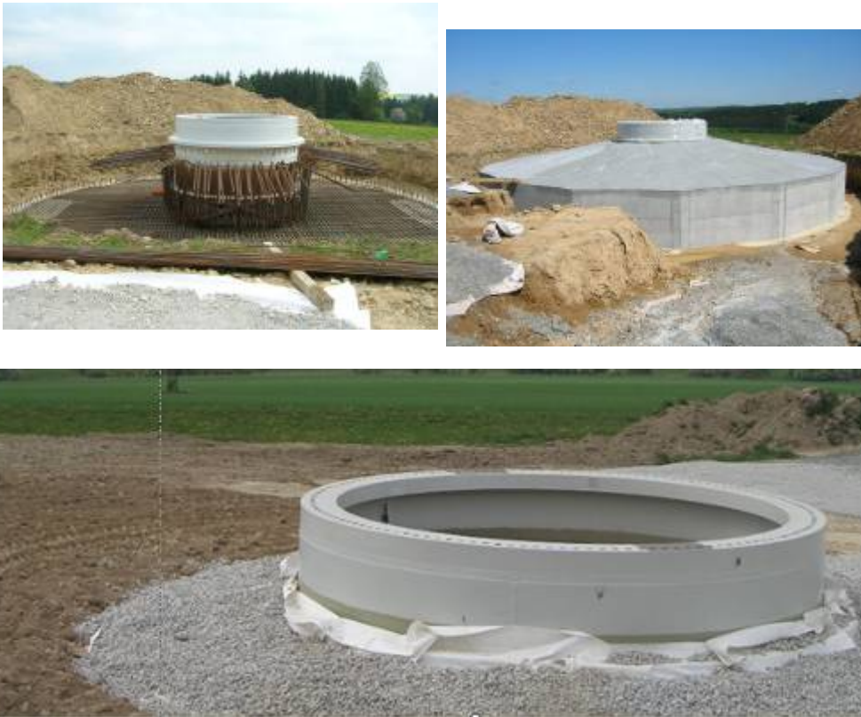
Kuva 3-5. Perustuksen rakentamisvaiheita (Kuva © Ventureal).
