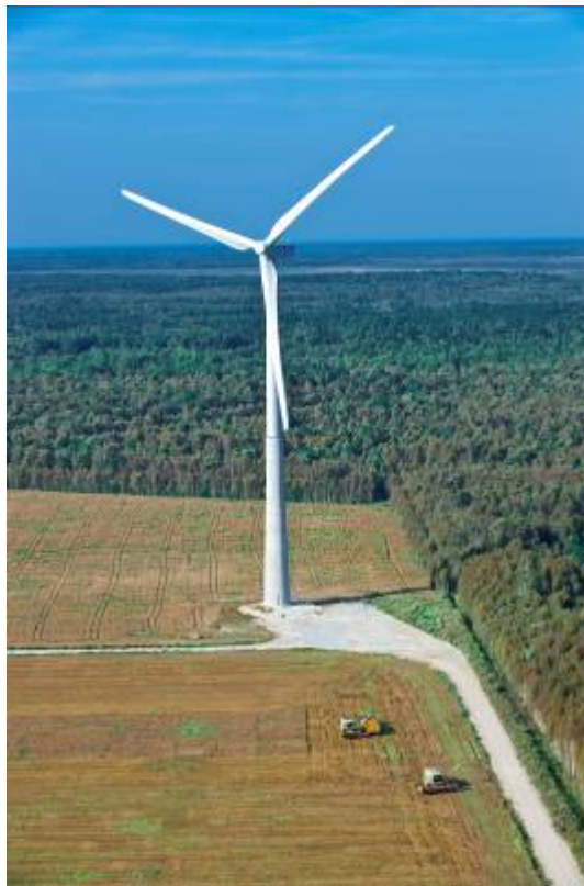
Kuva 3-4. Vasemmalla tuulivoimala, jossa tornista noin kolmasosa on betonia ja ylimmät osat terästä. Oikealla puolella tuulivoimalan periaatekuva (Kuva © Winwind Oy).
