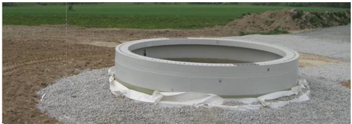
Kuva 3-7. Perustuksen rakentamiskuvauksia (Kuva © Ventureal)
