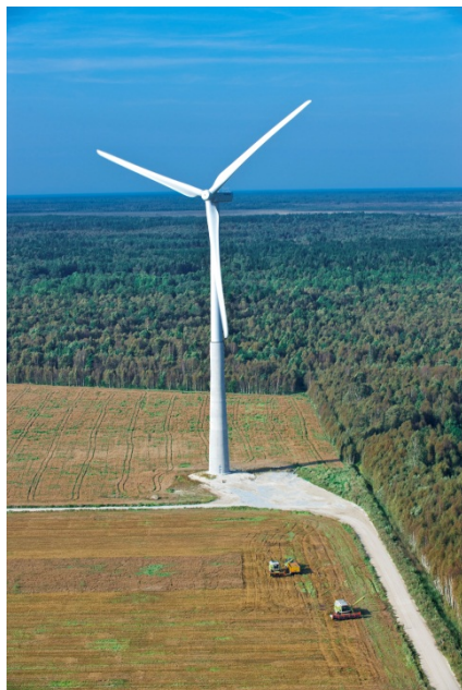
Kuvat 2-3. Kuva teräsbetonirakenteisesta tuulivoimalasta ja periaatekuva tuulivoimalasta (Lähde: Win-Wind Oy).
