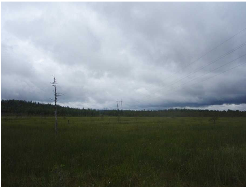
Kuva 3-1. Olemassa oleva voimajohtolinja Vuolijoen sähköasemalle ylittää Korkeamäensuon.
