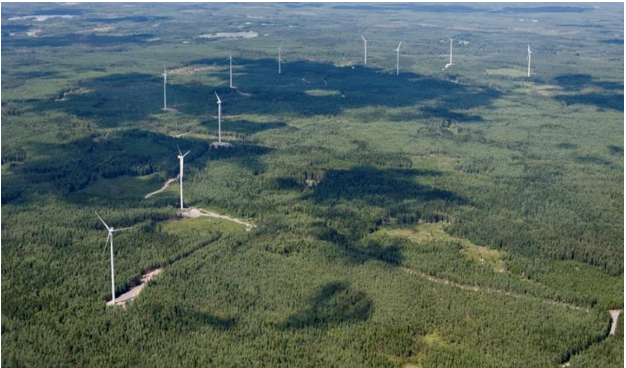
Kuva 1. Tuulipuisto metsäisellä alueella. Stengårdsholman tuulipuisto Ruotsissa, 10 voimalaa à 2 MW, napakorkeus 125 m, roottorin halkaisija 90 m. Kuva: EON
