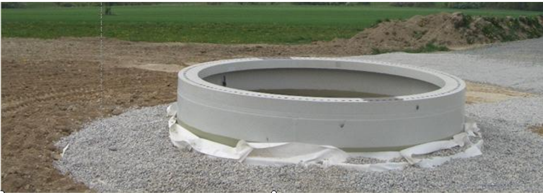
Kuva 5. Perustuksen rakentamisvaiheita ( Ventureal )
