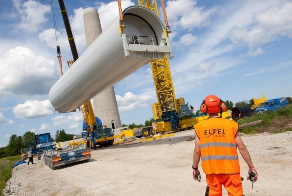
Kuva 17. Tornilohkon nostaminen (Kuva: Eltel Networks Oy)
