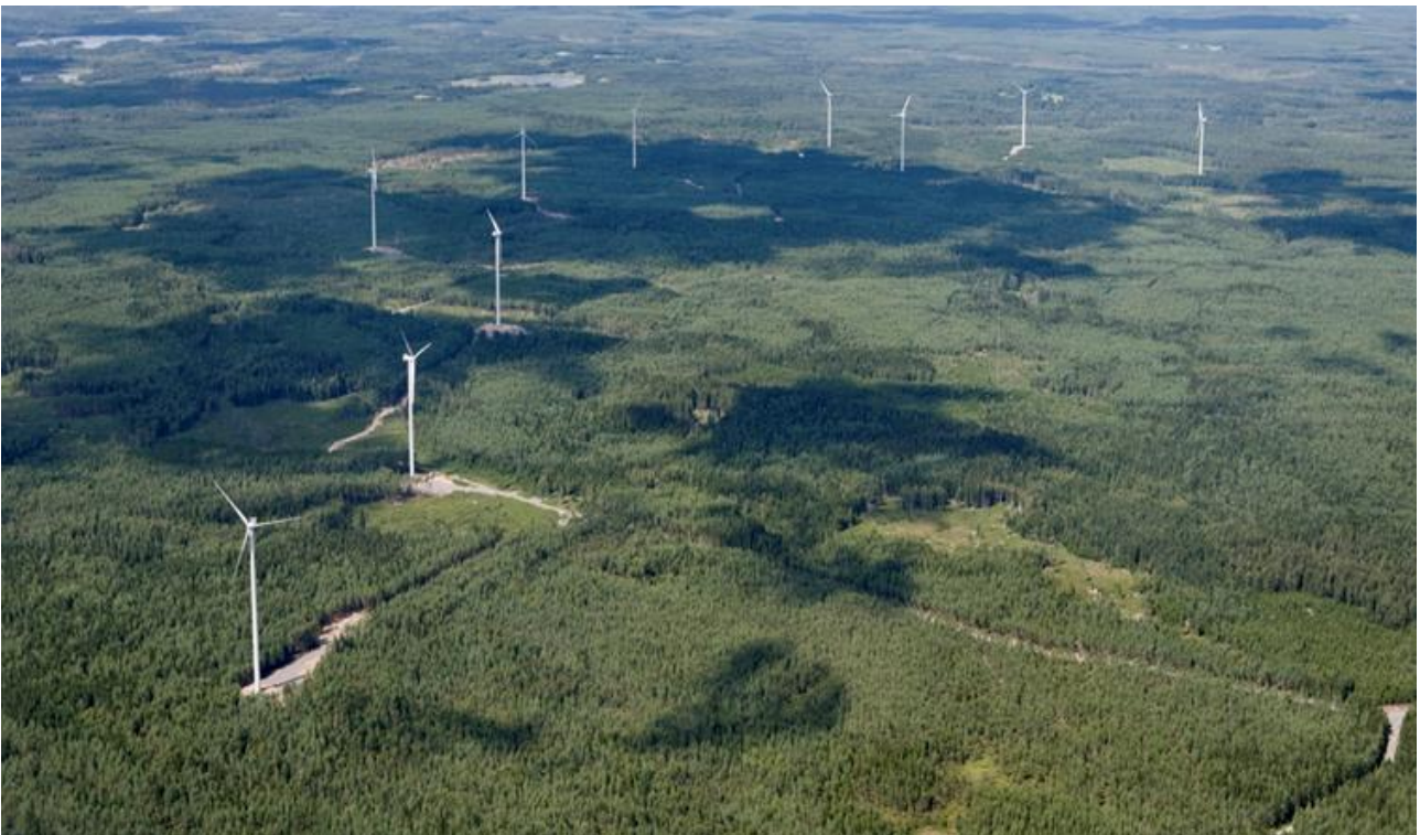
Kuva 1. Tuulivoimapuisto metsäisellä alueella. Stengårdsholman tuulipuisto Ruotsissa, 10 voimalaa à 2 MW, napakorkeus 125 m, roottorin halkaisija 90 m. Tuulivoimalat sijoittuvat noin 600–700 m etäisyydelle toisistaan. Kuva: EON
