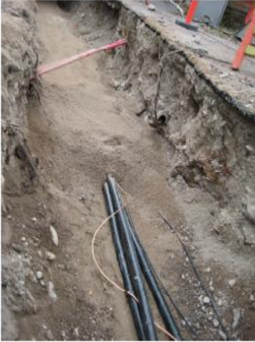
Kuva 15. Puiston sisäisessä sähkönsiirrossa käytetään pääasiassa yhdysteiden viereen asennettavia maakaapeleita (Kuva: www.reka.fi )
