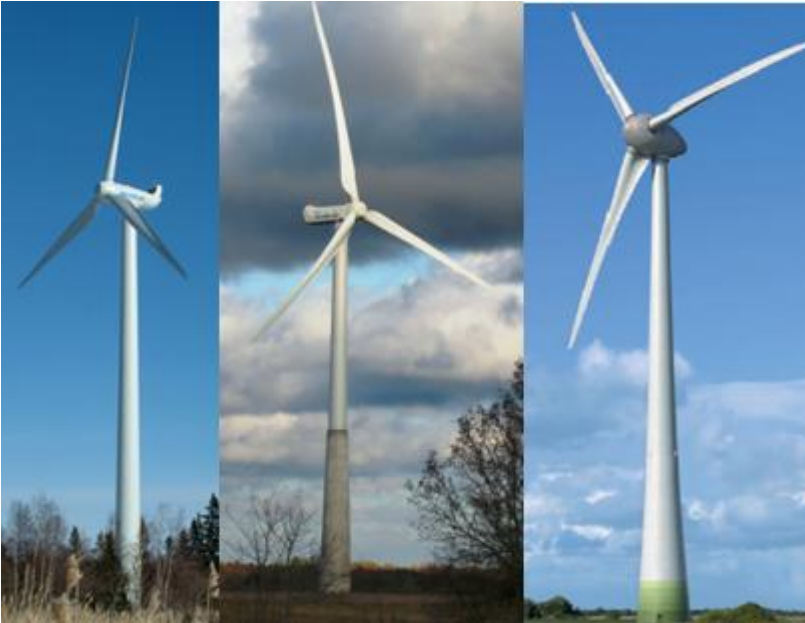
Kuva 5. Tuulivoimalan tornityyppejä, vasemmalla terästorni, keskellä betoni- ja terästornin yhdistelmä ja oikealla täysbetonitorni. (kuvat WinWinD ja Enercon)
