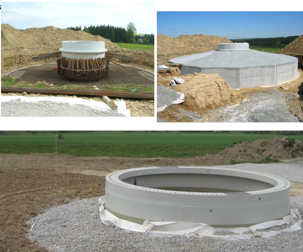
Kuva 6. Perustuksen rakentamisvaiheita ( Ventureal )
