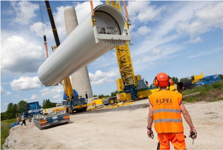
Kuva 19. Tornilohkon nostaminen (Kuva: Eltel Networks Oy)
