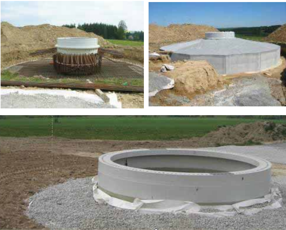
Kuva 3-11. Perustuksen rakentamisvaiheita. (Kuva © Ventureal)
