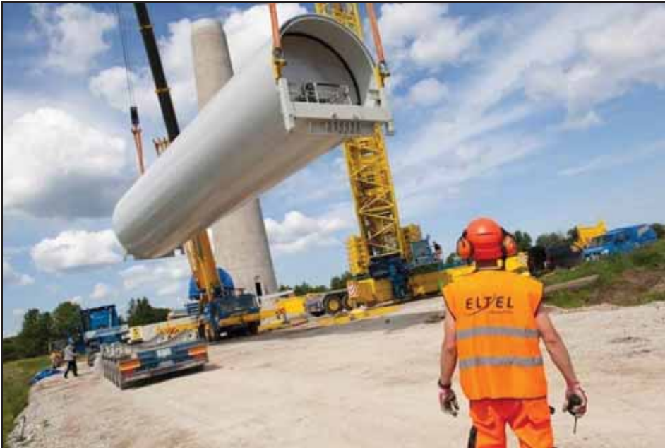
Kuva 3-15. Tornilohkon nostaminen (Kuva: Eltel Networks Oy).
