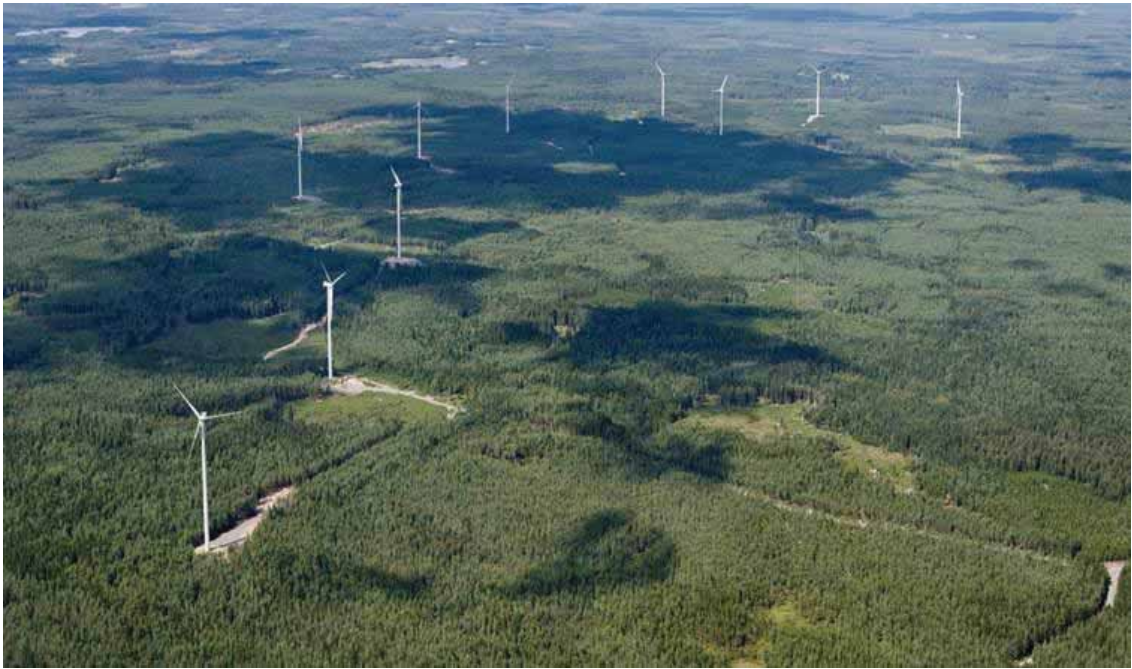
Kuva 3-7. Tuulivoimapuisto metsäisellä alueella. Stengårdsholman tuulivoimapuisto Ruotsissa, 10 voimalaa à 2 MW, napakorkeus 125 m, roottorin halkaisija 90 m. Kuva: © EON.
