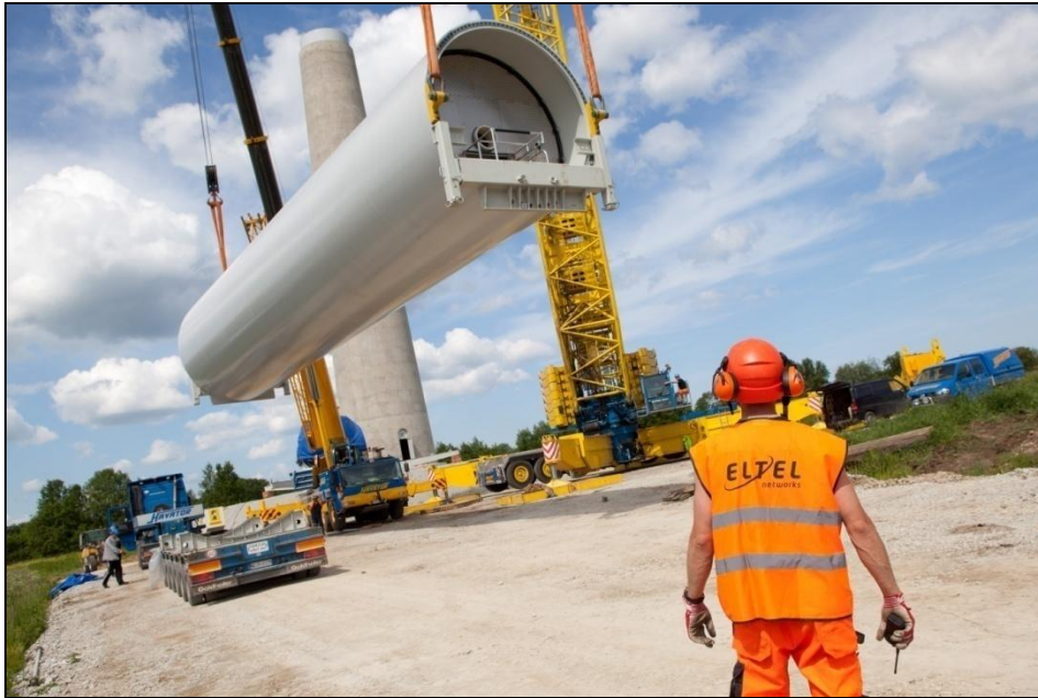
Kuva 3-14. Tornilohkon nostaminen (Kuva: Eltel Networks Oy).
