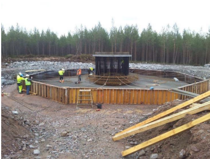
Kuva 19. Tuulivoimalatyömaa (kuva Honkajoelta, kuva Taaleritehtaan)
