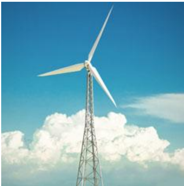
Kuva 5. Tuulivoimalaitos, jossa ristikkorakenteinen torni. Kuva: Rautaruukki Oyj (www.ruukki.fi)
