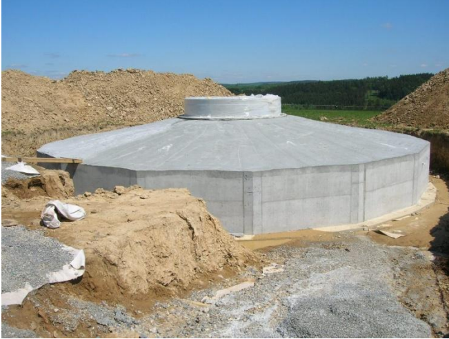
Kuva 6. Tuulivoimalan betonilaatta ennen sen peittämistä maa-aineksilla. Kuva: Vetna energie HL ( www.vehl.cz )
