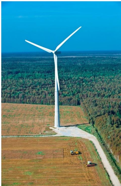
Kuva 4. Vasemmalla 3 MW:n tuulivoimalaitos, jonka tornin alaosa on betonia ja yläosa terästä, napakorkeus ja roottori ovat 100 m. ( Kuva: WinWinD ). Oikealla on periaatekuva tuulivoimalasta (Kuva: planete-energies.com)
