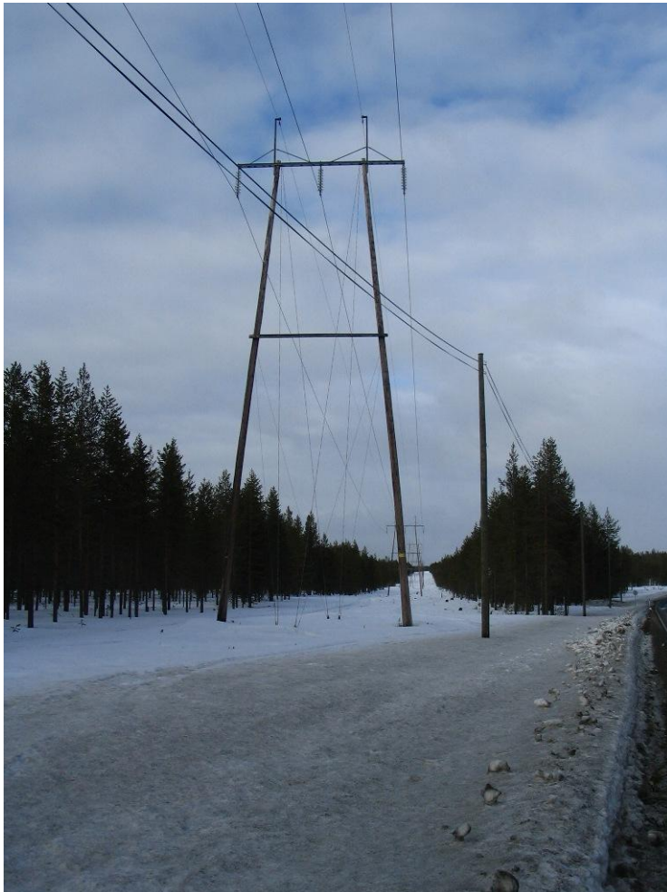
Kuva 7. Meltaus-Lintuselkä 110 kV:n voimajohto.
