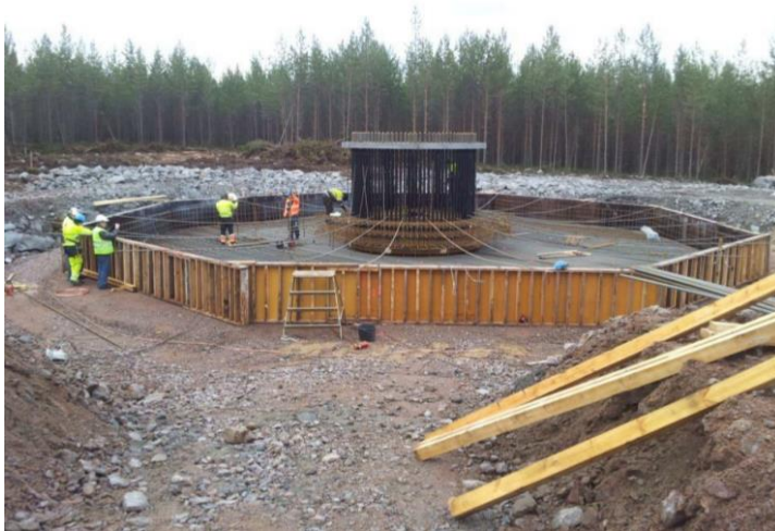
Kuva 22. Tuulivoimalatyömaa (kuva Honkajoelta, kuva Taaleritehtaan)
