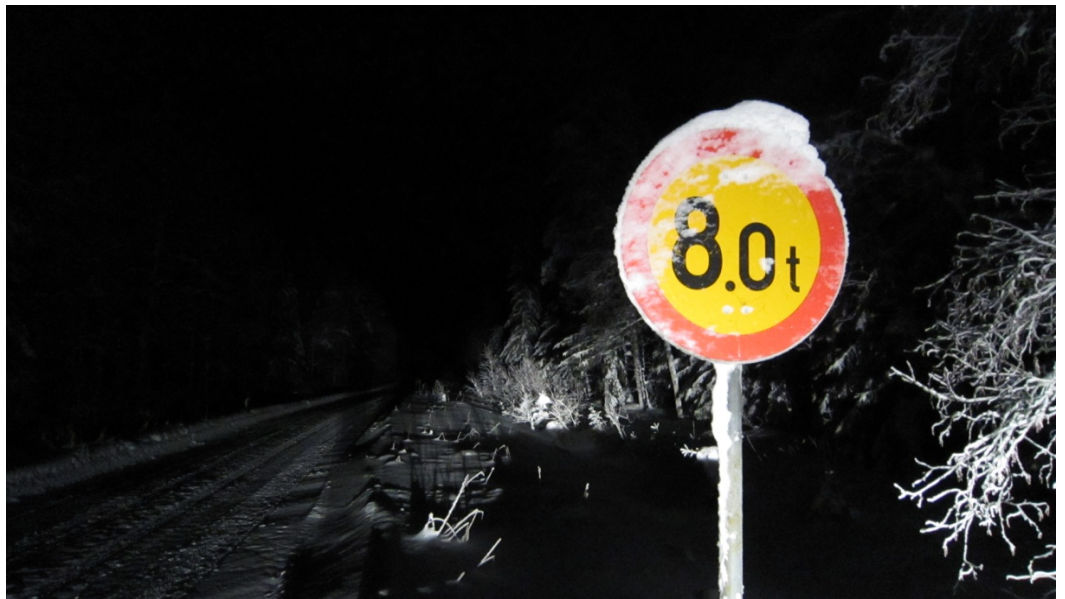
Kuva 7. Rullan metsätie on vahvistettava. Tien ajoneuvojen suurin sallittu massa on 8 t, kun tuulivoimalan konehuone yksin voi painaa yli 120 t (Kuva J. Kjellman).
