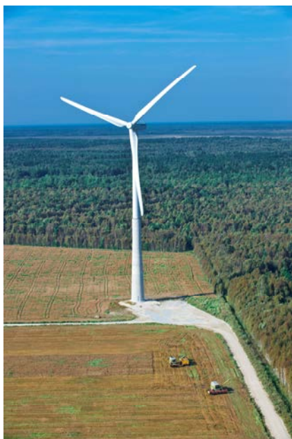
Kuva 2. Kuva 3 MW:n tuulivoimalasta, jonka tornin alaosa on betonia ja yläosa terästä sekä periaatekuva tuulivoimalasta (Lähteet: WinWind Oy, planete-energies.com)
