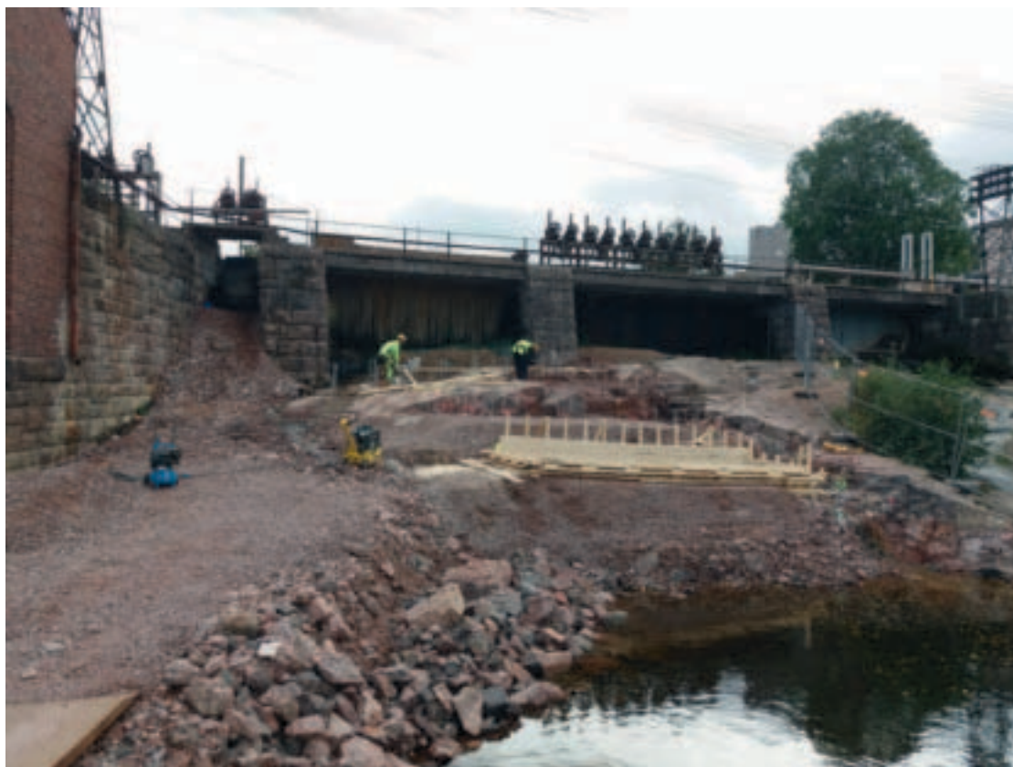
Kuva 2. Rakenteilla olevan Billnäsin kalatien pohjatyöt aloitettiin kesällä 2018. Keskelle patoa rakennettava kalatie mahdollistaa kalojen kulun turbiinien ohi myös alavirtaan. (Kuva P. Nordström)
