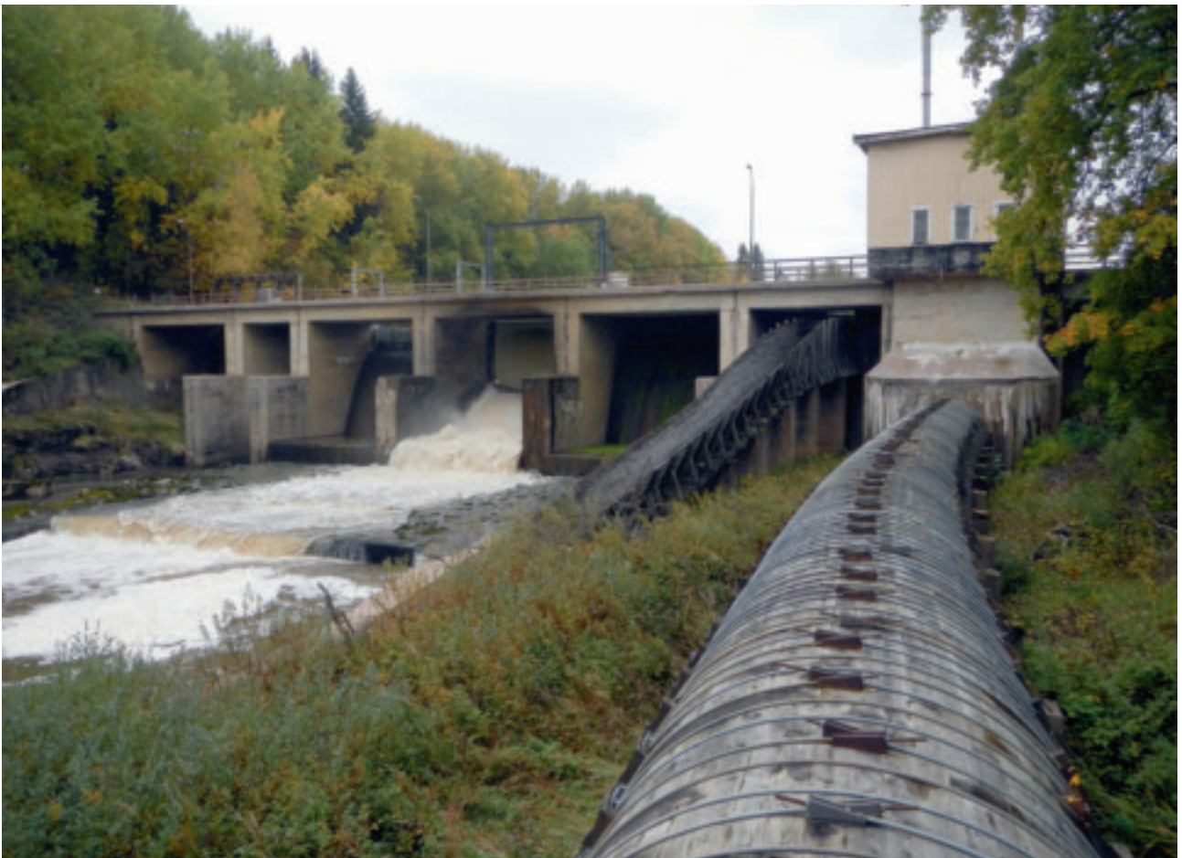
Monet pienvoimaloista ovat jokilaitoksia, jotka toimivat joen tulovirtaaman varassa. Askalan voimalaitoksen pato ja voimalaan johtava vedenottoputki Paimionjoessa. 1,1 megawatin voimala avattiin vuonna 1936. Kuva: Virpi Sahi 2017.
