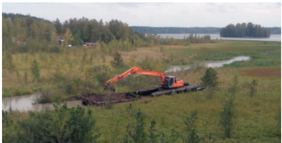
Kuva 1. Ponttoonikaivuri kaivaa uutta kanavaa Valkeakosken Tyköljänjärven rantaluhtaan. Järven lasku-uoma näkyy vieressä, siihen ei ruoppauksessa kosketa, koska siinä kasvaa runsaasti sahalehteä, joka on harvinainen vesikasvi ja tärkeä laji viherukonkorennon lisääntymiskierrossa. Kuva: Eeva Einola.
