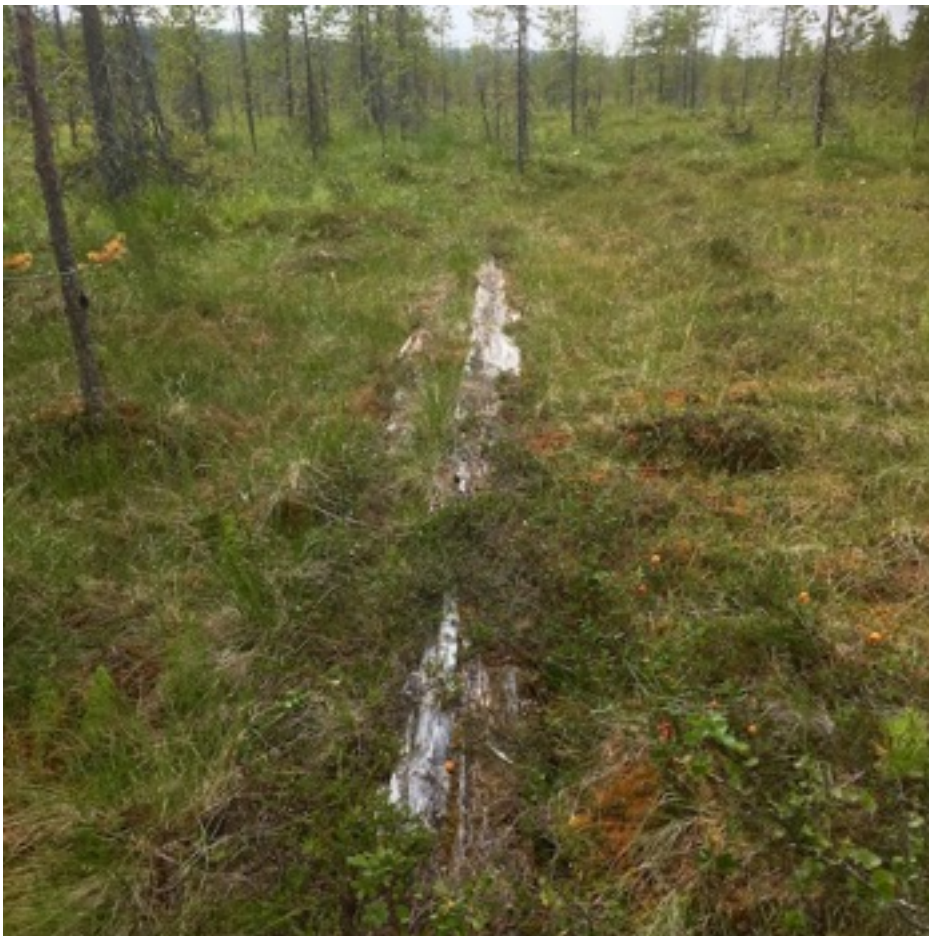
Kuva: Pitkospuiden maatonutta linjausta suolla. Pohjoisesta.
