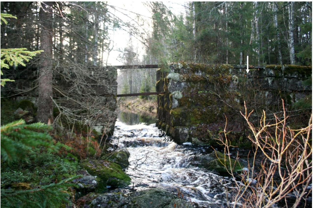
Kuva 33. Hetonjoen jyhkeä säännöstelypato jaksolla 6. Tulva-aukko oikealla (nuoli).
