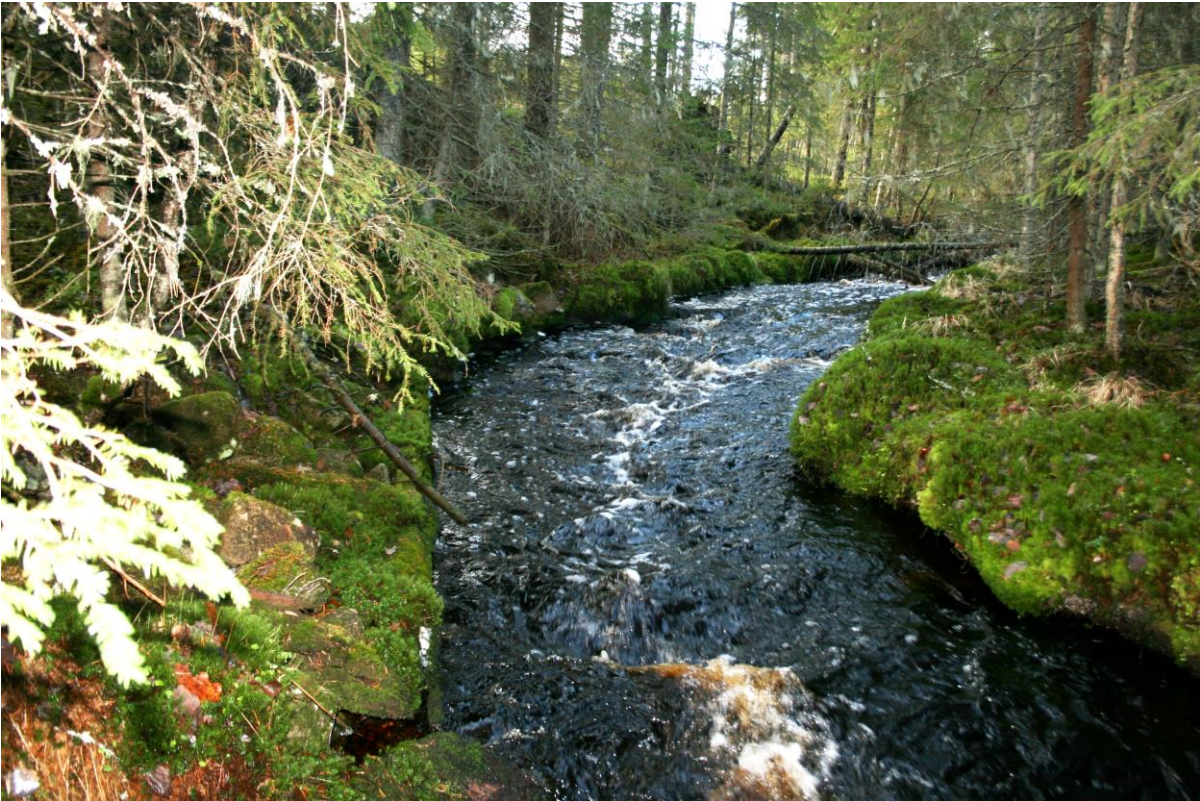
Kuva 28. Nivamaista osuutta Hetonjoella heti jakson 3 alussa. Edessä vasemmalla perkauskivikkoa ja puurakenteita, joilla oli vahvistettu virranpuoleista rantapenkerettä.
