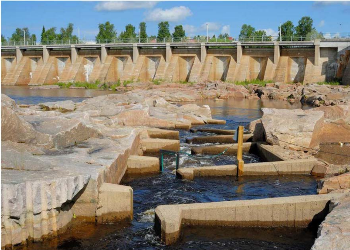
Kuva 13. Merikosken yläkalatien alaosaan asennettu PIT-lukijayksikkö. Lähde. Orell ym. (2014).
