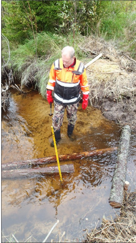
Kuvat 8 ja 9. Kunnostustyö meneillään Peuraluomassa (vas.) ja puusuistein kunnostettua Peuraluomaa (oik.). Alue on vanhaa majavapadon allasaluetta ja uoman reunoilla näkyy vielä tummaa laskeutunutta lietettä. Varsinainen vesiuoma on kuitenkin jo puhdistunut virtauksesta.
