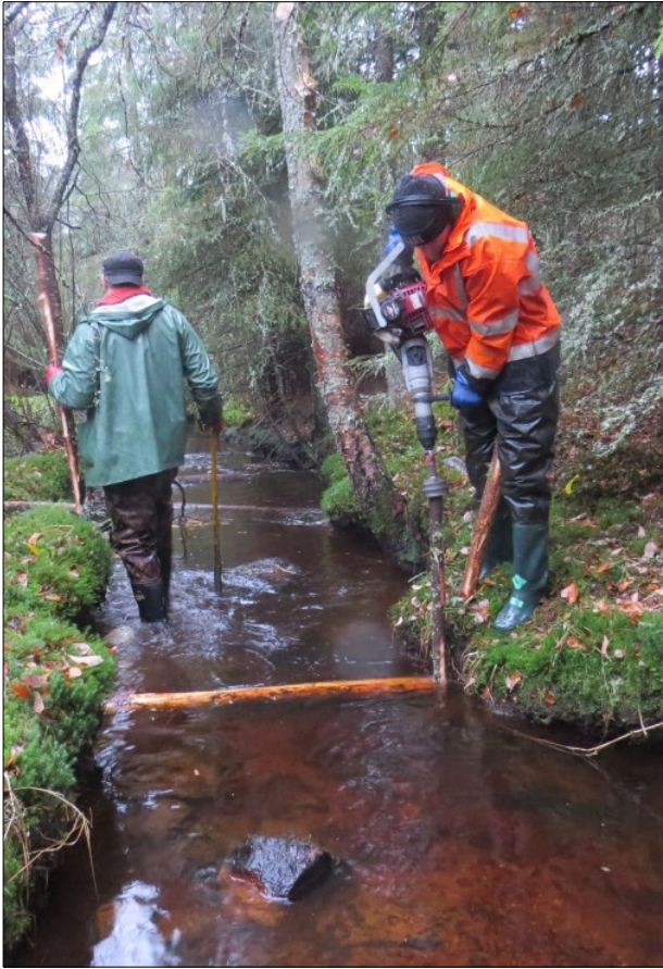
Kuva 1. Puutolppia isketään puroon polttomoottoriporavasaralla.
