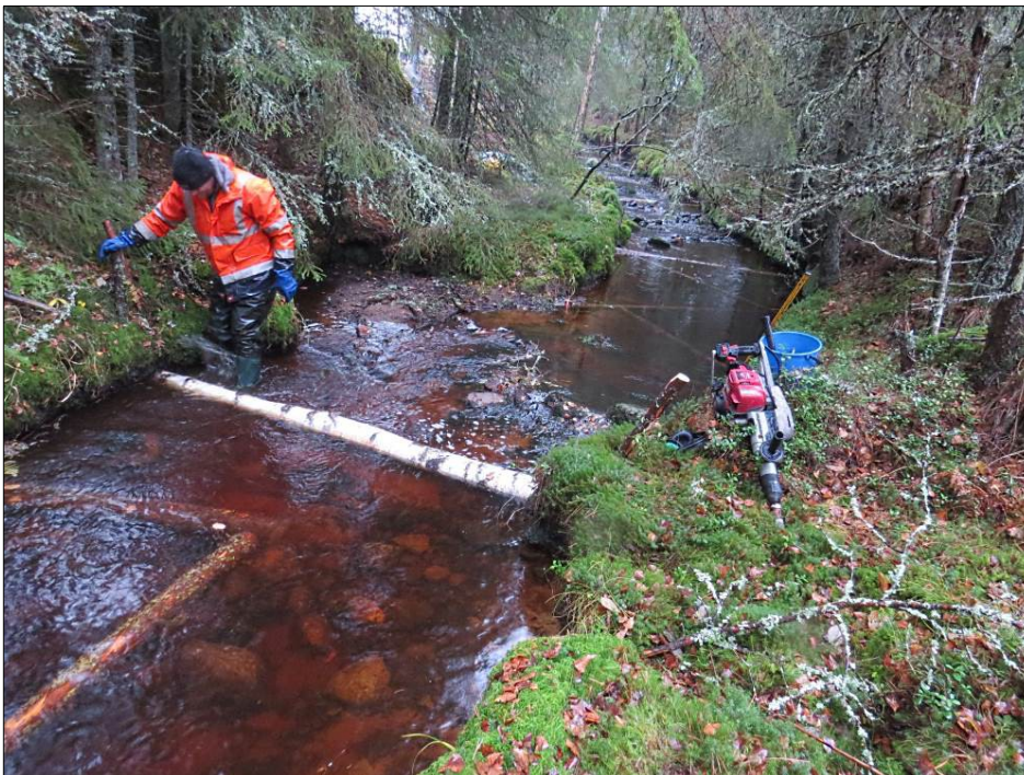
Kuva 2. Puusuisteiden asennusta Latikanojalla.
