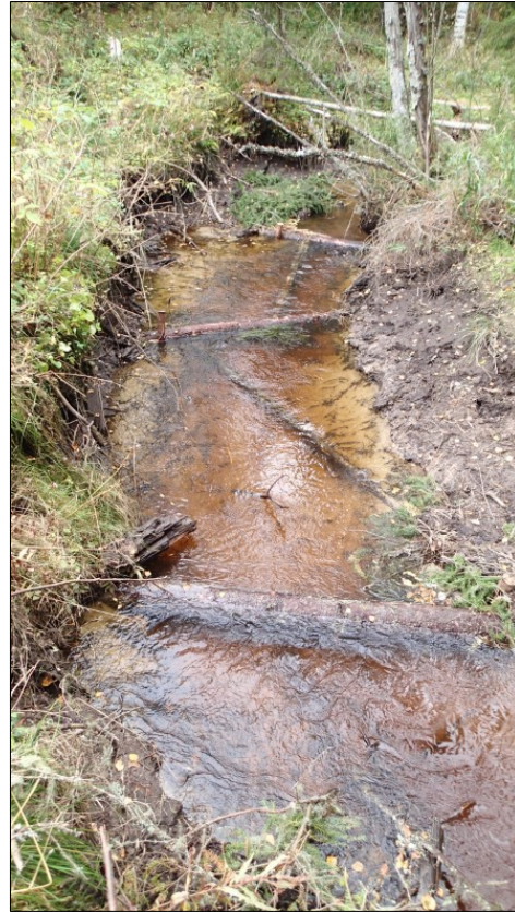
Kuvat 8 ja 9. Kunnostustyö meneillään Peuraluomassa (vas.) ja puusuistein kunnostettua Peuraluomaa (oik.). Alue on vanhaa majavapadon allasaluetta ja uoman reunoilla näkyy vielä tummaa laskeutunutta lietettä. Varsinainen vesiuoma on kuitenkin jo puhdistunut virtauksesta.
