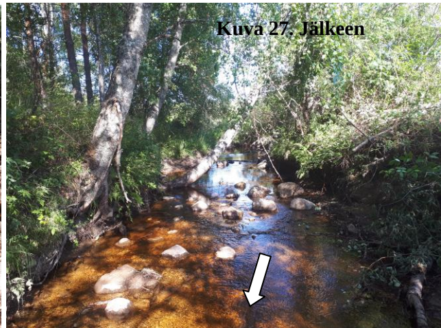
Kuva 26-27. Vuosjoen soraikkoalue Viitasaaren tien alapuolella ennen ja jälkeen kunnostuksen. Luontaisia kynnyskohtia kivettiin lisää ja uoman avonaisille, suojattomille sivuille laitettiin suojakiveä.
