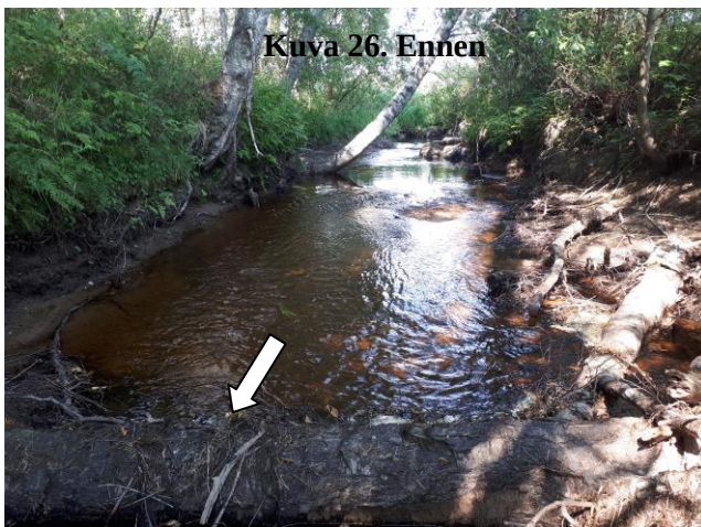
Kuva 26-27. Vuosjoen soraikkoalue Viitasaaren tien alapuolella ennen ja jälkeen kunnostuksen. Luontaisia kynnyskohtia kivettiin lisää ja uoman avonaisille, suojattomille sivuille laitettiin suojakiveä.
